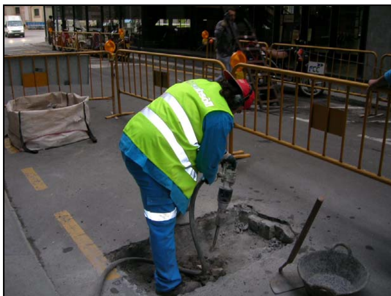
Fotografia 6: Obertura pou d'accés galeria 2
