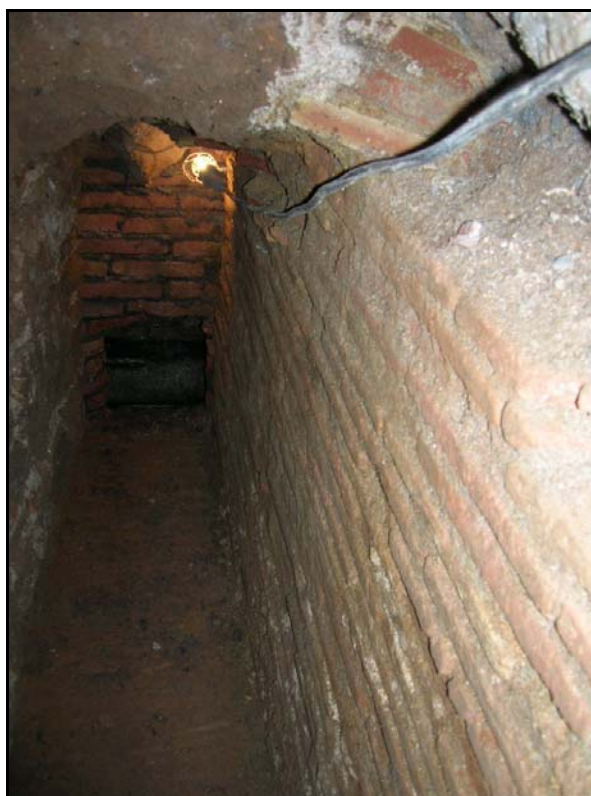
Fotografia 5: Interior galeria 1 on s'observa la paret de l'embornal UE107, el mur UE105 i el nivell d'argiles UE110.
