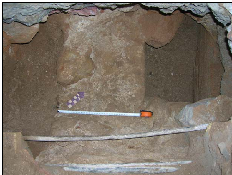
Fotografia 2: Pou accés galeria 1 amb vista en planta dels murs UE105 i UE106
