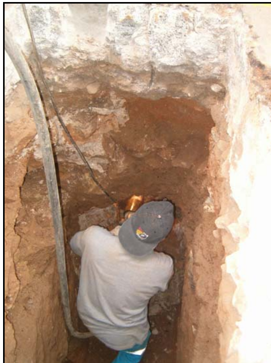
Fotografia 11: Desmuntatge mur UE211
