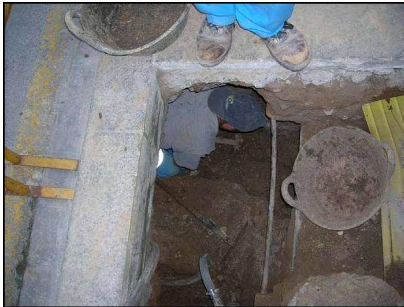
Fotografia 3: Desmuntatge mur UE106
